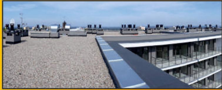
Begrünte und genutzte Dächer mit belastbarer Isolierpappe gemäß EN 13969:2004/A1:2006 – T ( Wasserabichtung )
